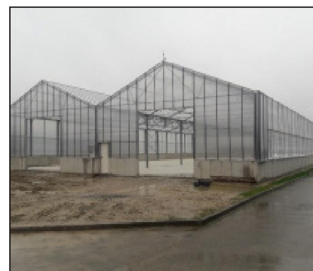
7. Serre après la mise en place de la dalle de béton (mars 2020)
